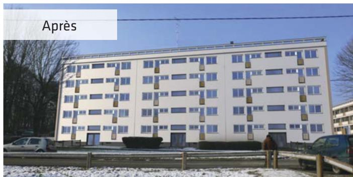
Les travaux des façades sont de deux ordres : isolation des bâtiments et des toits par l'extérieur, incluant le remplacement des fenêtres des toilettes du bâtiment D, et rafraîchissement général (peinture des balcons et loggias, remplacement des garde-corps et des menuiseries extérieures des cages d'escalier).
