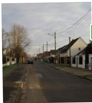
TRAVAUX SUR LE RÉSEAU DE DISTRIBUTION D'EAU POTABLE septembre 2020 Avenue du Rêve
