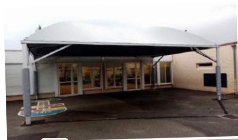
MISE EN PLACE D'UN PRÉAU dans la cour de la maternelle de l'école Victor Hugo
