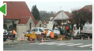
TRAVAUX D'INSTALLATION DE LA FIBRE OPTIQUE place de l'église, boulevard VH, place de l'école et monument aux morts
