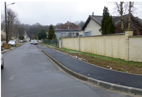
CRÉATION D'UN TROTTOIR AVENUE CLÉMENT ADER
