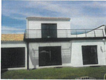
Partie de construction en terrasse constituant le balcon de l'étage supérieur
