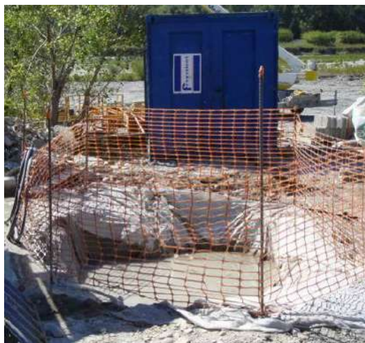
Photo 16 : Fosse à béton (Source : SYSTRA)
