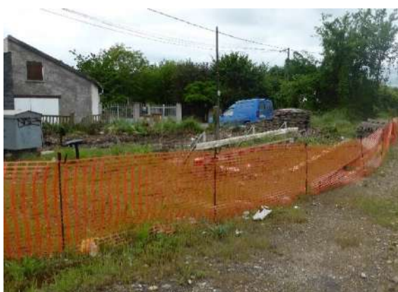
Photo 18 : Exemples de barrières de chantier et de panneaux indicatifs (Source : SYSTRA)
