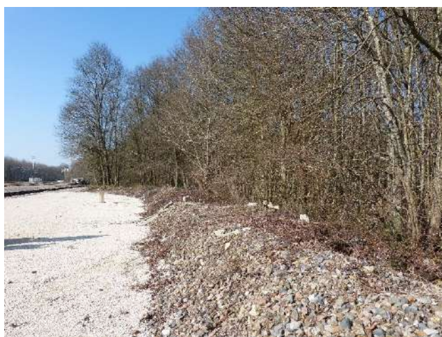
Photo 12 : Cordon de ballast en bordure nord du faisceau de voies (© Systra, 2018)
